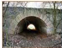
Etwas bei km 114,9 folgt ein einfacher Grabendurchlass, ausgeführt als Betonrohr mit Durchlassbögen an beiden Enden (lichte Weite 1,00m, lichte Höhe 1,20m). Die Durchlassbögen sind mit behauenen Natursteinen verkleidet.
