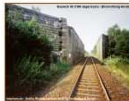
Etwas weiter südlich bei km 111,8+96,28 befindet sich das Durchlassbauwerk (Plattendurchlass) für das Flüsschen Grindau mit einer lichten Weite von 4,00m, einer lichten Höhe von 2,00m und einer Breite von 27,5m. Die Durchlassbögen sind außen mit behauenen Natursteinen verkleidet, die Dammschüttung ist in der inzwischen überwachsenen Trassenflucht nur noch andeutungsweise erkennbar.
