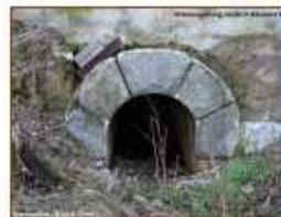
Nur etwa 250m entfernt (km 115,2+43,55) liegt die Querung der "Größen Beeke" als Plattendurchlass mit einer lichten Weite von 4,00m, einer lichten Höhe von 2,20m und einer Breite von 27,5m. Auch hier sind die Durchlassbögen mit behauenen Naturstein verziert, leider fehlen bereits Teile davon.
